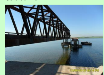
ESTRUTURA: No espaço que houve a implosão, será instalada conforme foto uma ponte de estrutura metálica que foi construída durante 8 meses no canteiro de obra.
