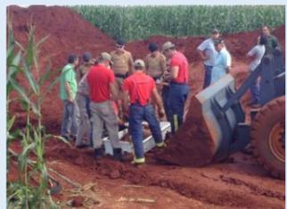
Conforme os bombeiros, um dos homens estava na parte de baixo da obra quando parte do barranco cedeu, deixando-o com metade do corpo soterrado.
