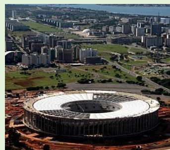
Primeira morte por acidente de trabalho ocorreu na Arena Mané Garrincha em Brasília quando em construção.
