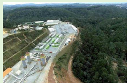
Vista geral da Termoverde Caieiras
