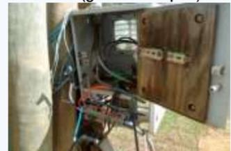
Durante as atividades periciais, constatou-se a existência de instalações elétricas em condições inseguras de funcionamento, com partes energizadas (vivas) expostas e acessíveis e condutores elétricos dispostos de maneira a obstruir a circulação de pessoas e materiais, além de fiações expostas e extensões de energia ligadas de forma improvisada, aumentando os riscos de acidentes por eletrocussão.
