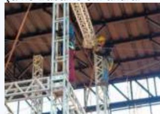
Operários foram flagrados sem a ancoragem do cinto de segurança na montagem de estruturas metálicas, expondo os trabalhadores ao risco iminente de queda.
