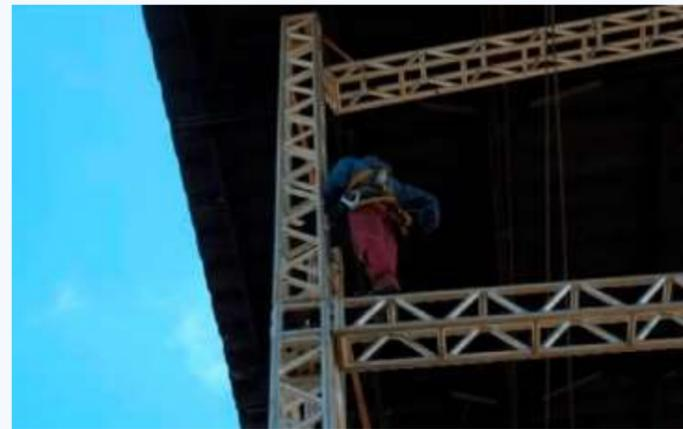
O MPT flagrou trabalhadores sem equipamentos de proteção individual (EPIs), como protetores auriculares para proteção de ruídos e luvas para proteção em atividades com risco de lesão dos membros superiores. Também foi apontada a ausência de rodapés nas proteções coletivas (guarda-corpos).
