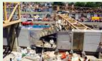
Caminhão com caçamba suspensa derrubou passarela no Rio, em 2014, deixando cinco mortos, vários feridos e muito prejuízo
